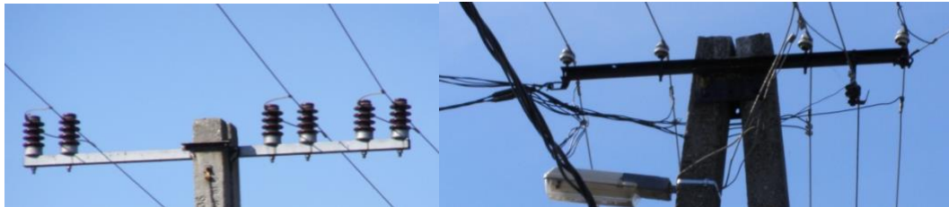
2. ábra: Nagyfeszültségű (A) és kiefeszültségű szabadvezetékek szigetelői (Göbl G felvételei)
